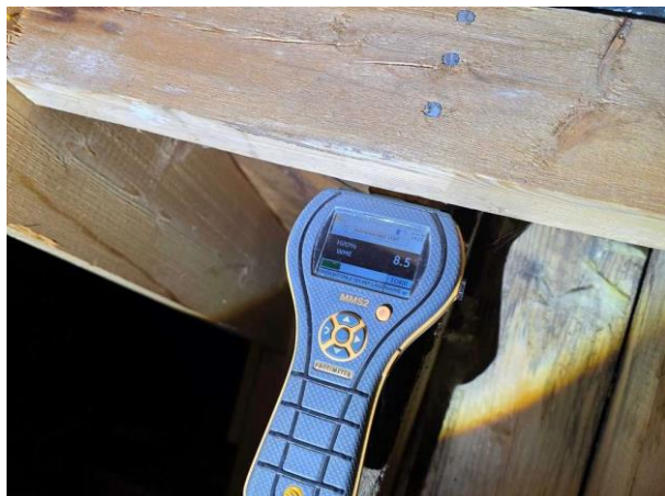
Bild 11: Utvändigt, Vind, Fuktmärken med påväxt på undertak
