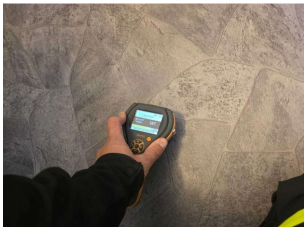
Bild 21: - Invändigt, Entréplan, Badrum, inga förhöjda fuktvärden vid besiktningsstillfallet.
