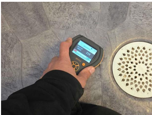
Bild 22: - Invändigt, Entréplan, Badrum, inga förhöjda fuktvärden vid besiktningsstillfallet.
