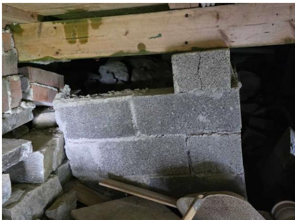
Bild 1: - Utvändigt, Grundmur/Hussockel, Krypgrund, se riskanalys Stora sättningar noterades i grunden. Dagvatten leds j bort från grunden...
