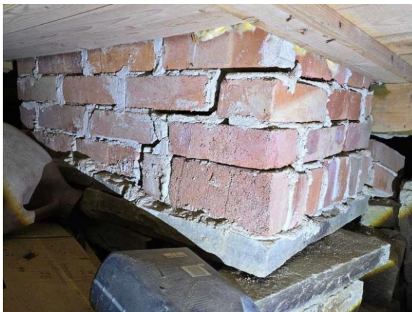
Bild 2: - Utvändigt, Grundmur/Hussockel, Krypgrund, se riskanalys Stora sättningar noterades i grunden. Dagvatten leds j bort från grunden...
