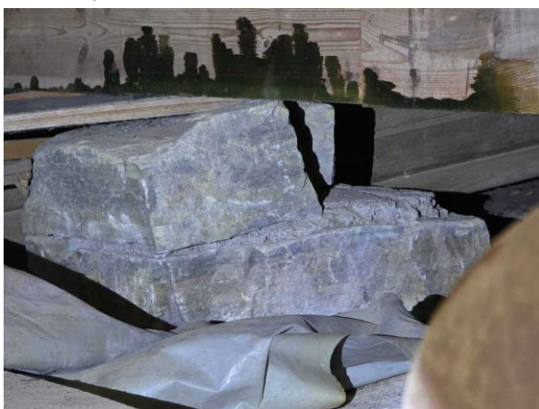
Bild 6: - Utvändigt, Grundmur/Hussockel, Krypgrund, se riskanalys Stora sättningar noterades i grunden. Dagvatten leds j bort från grunden...
