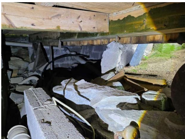
Bild 3: - Utvändigt, Grundmur/Hussockel, Krypgrund, se riskanalys Stora sättningar noterades i grunden. Dagvatten leds j bort från grunden...
