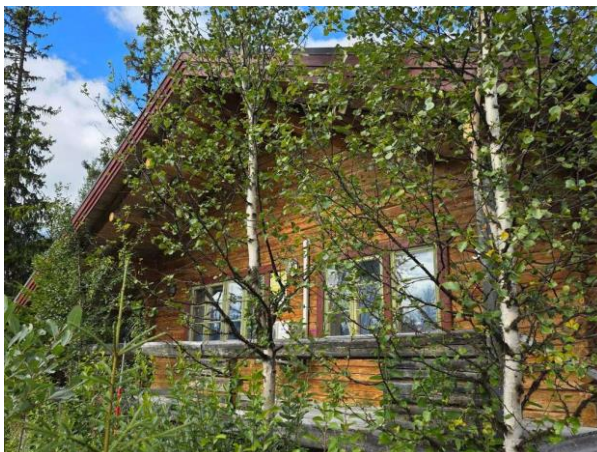
Bild 2: Utvändigt, Mark, Närliggande träd/växtlighet, se riskanalys.
