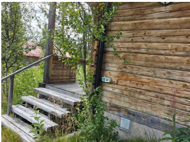
Bild 1: Utvändigt, Mark, Närliggande träd/växtlighet, se riskanalys.
