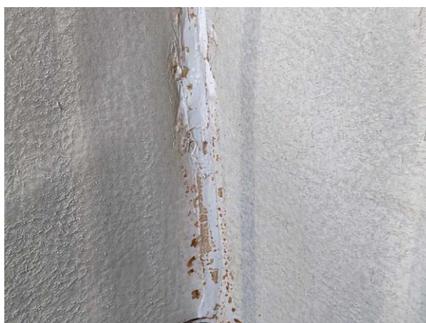
Bild 18: - Väggmatta tätad i dusch
