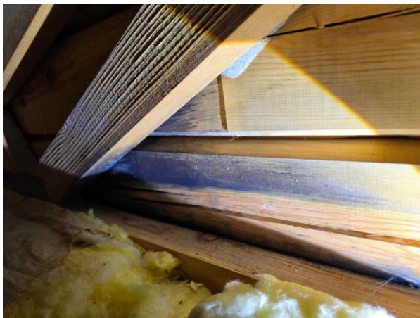
Bild 14: - Vind, Påväxt på gavel
