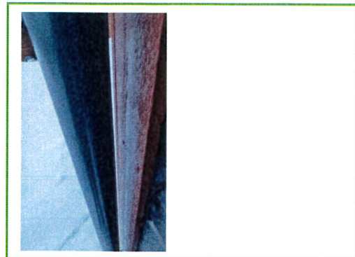
Bild 2: Stuprör felvridna.
