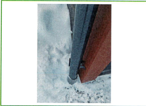
Bild 1: Lövrens ej monterades på stuprör.
